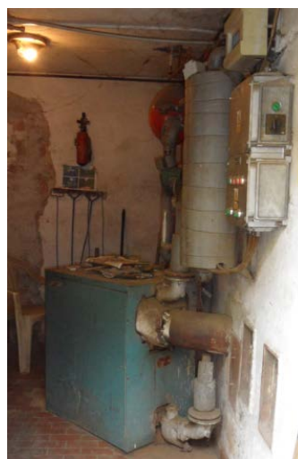
kotel na tuhá paliva i elektrokotel
