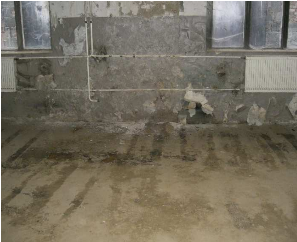
- Hochwasserschäden Erdgeschoss -
