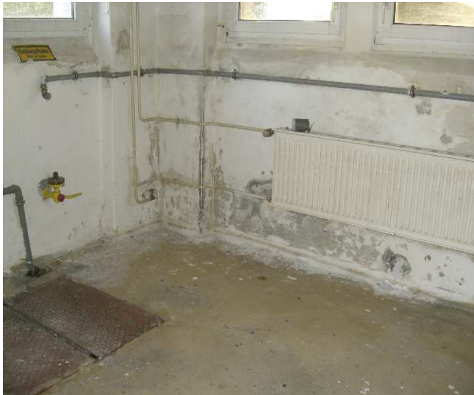
- Putz-und Feuchtigkeitsschäden Keller Schulgebäude -
