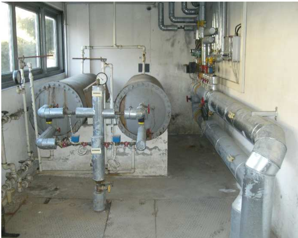
- Ansicht Heizungsübergabestation mit Warmwasserboiler Turnhalle -
