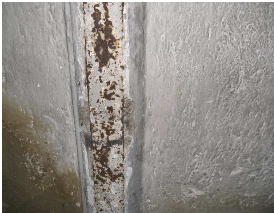
- Korrosionsschäden Kellerdeckenträger Schule -
