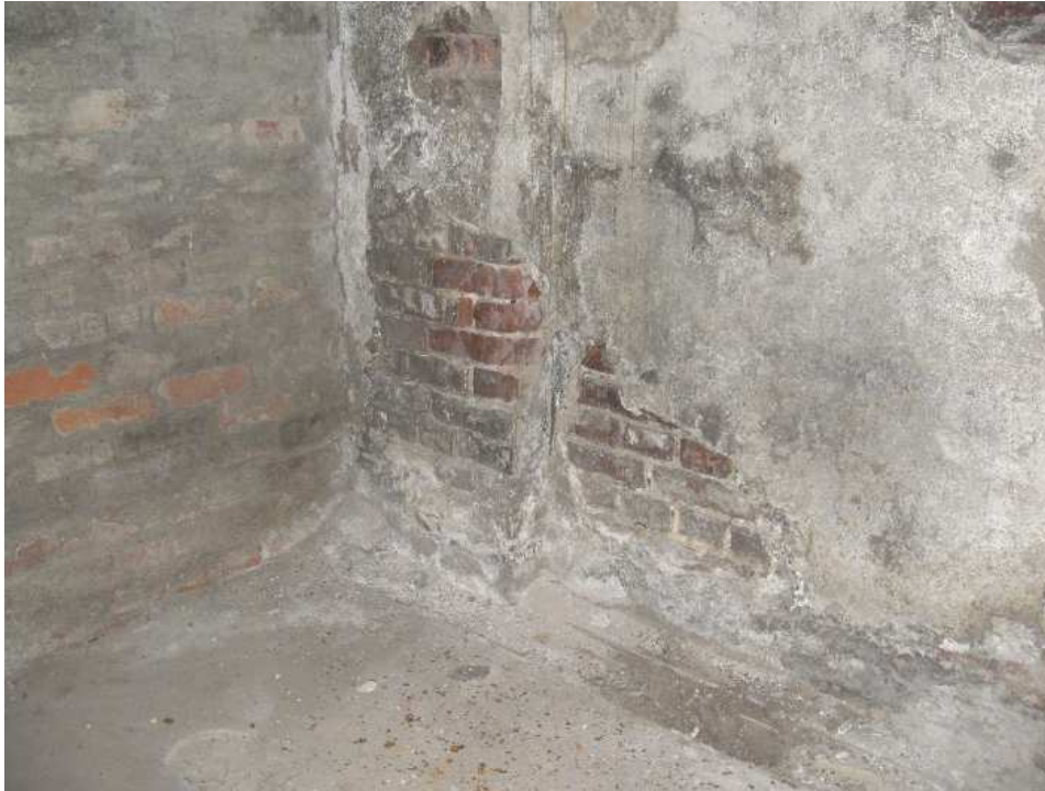
- Putz-und Feuchtigkeitsschäden Keller Schulgebäude -
