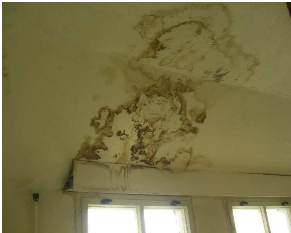
- Feuchtigkeitsschäden Dachgeschoss Schulgebäude -
