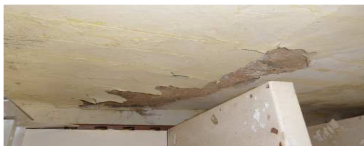
destrukce vlivem vlhka
