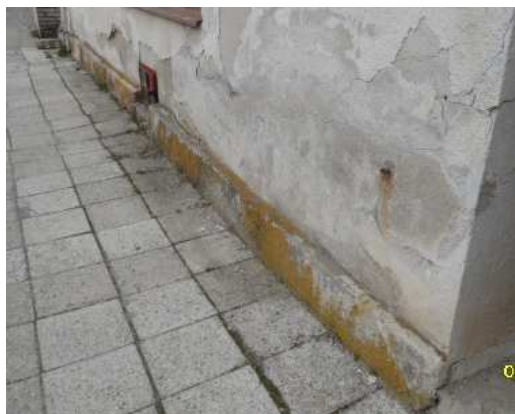
destrukce navlháním zdiva
