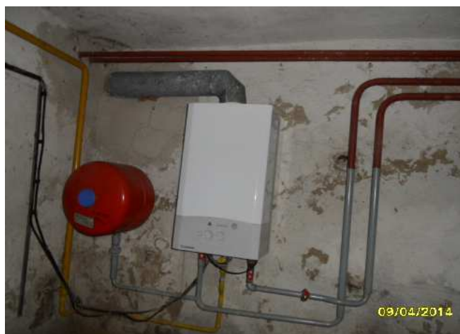
v suterénu nový kotel ÚT plynový
