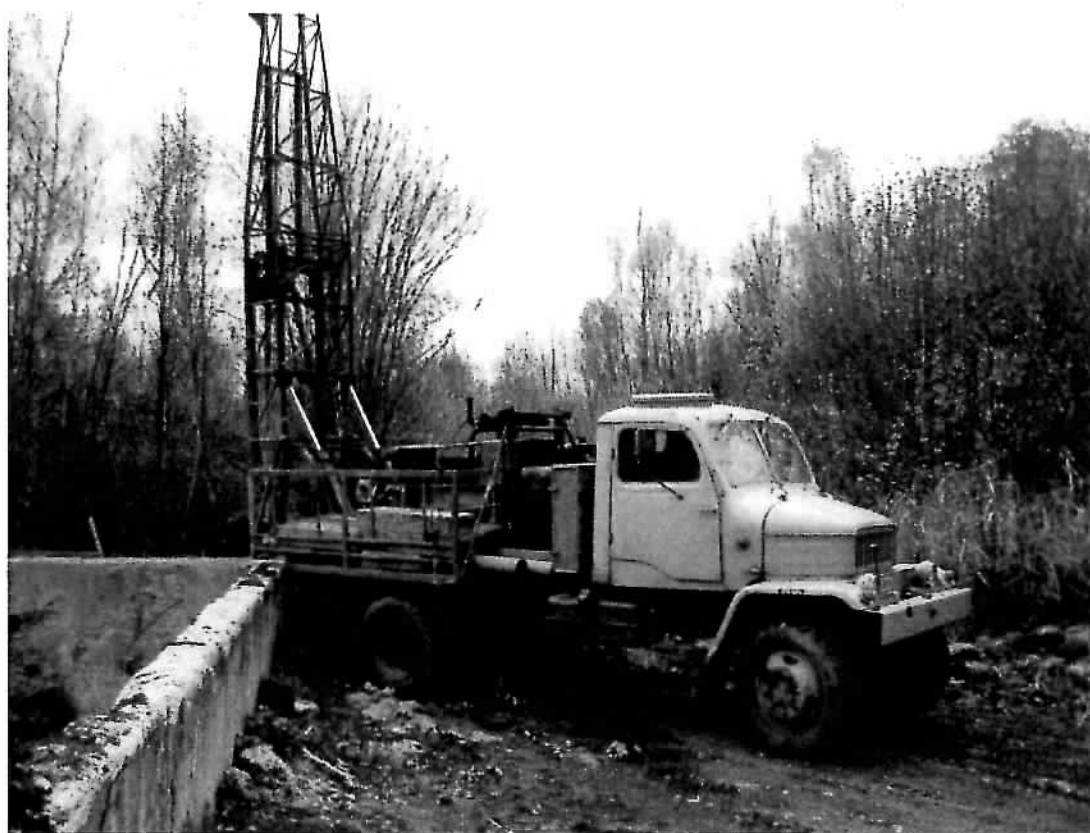
Obrázek č. 6: Hloubení hydrogeologického vrtu u úložiště ropných látek (p.č. 352)
