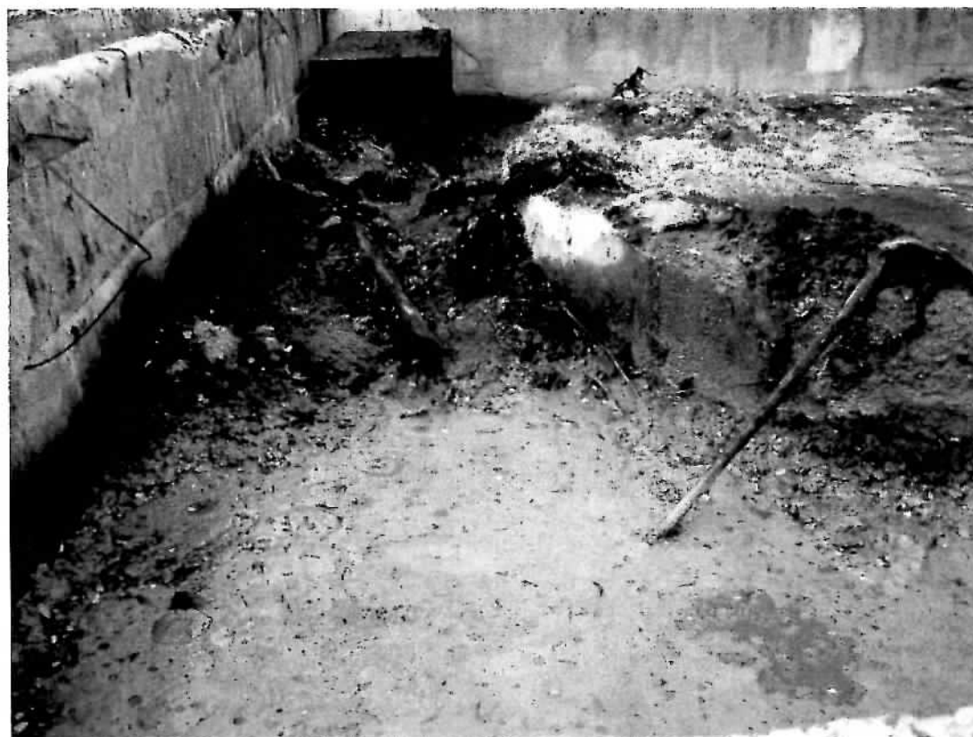
Obrázek č. 8: Detail havarijní jímky s ropnými látkami (p.č. 352)
