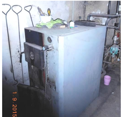
Kotel na tuhá paliva v suterénu objektu.
