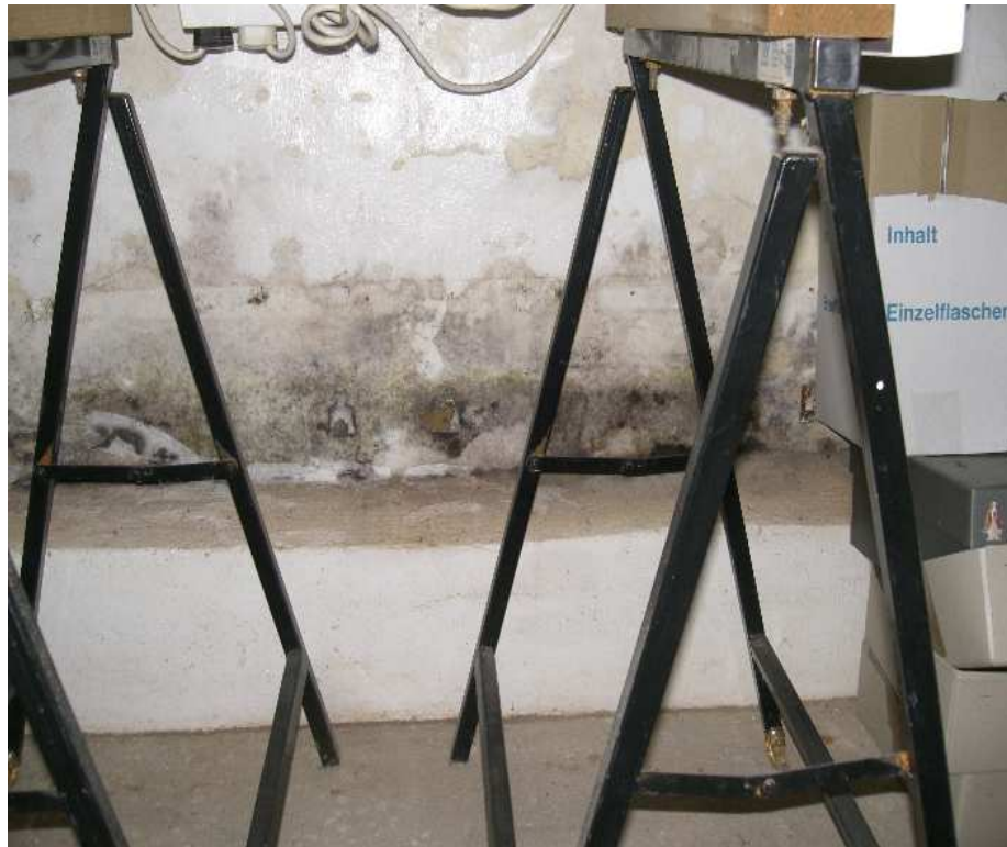
- Aufsteigende Feuchtigkeit Innenwände EG Wohnteil -
