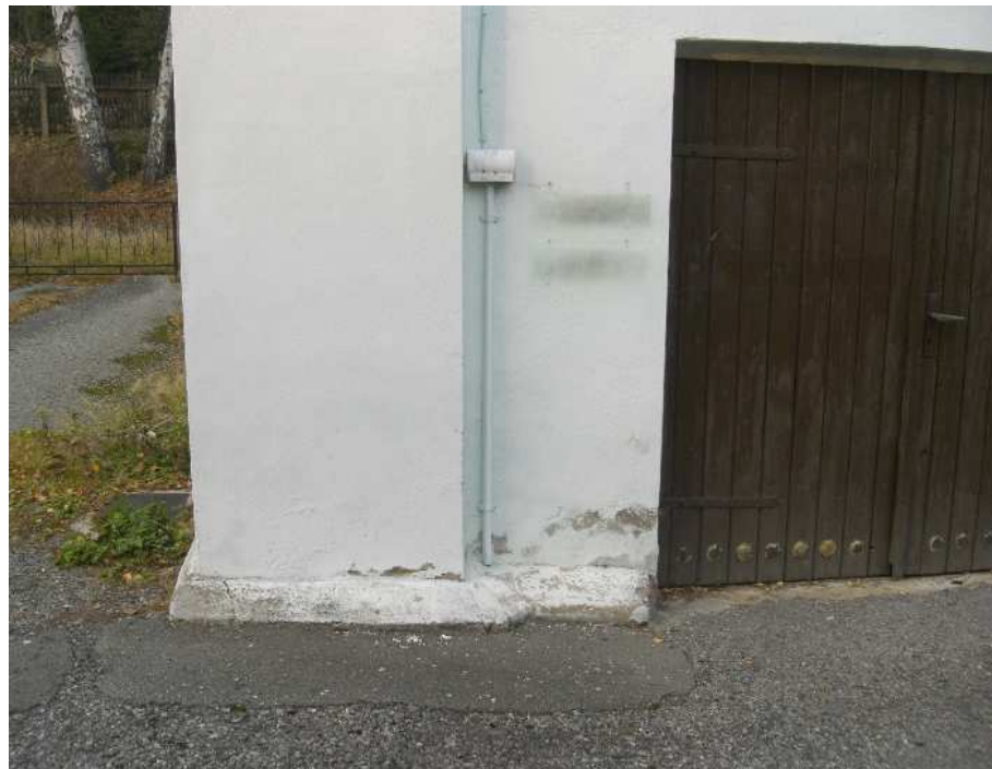
- Feuchtigkeitsschäden Spritzwassersockel Außenwand Wohnteil -
