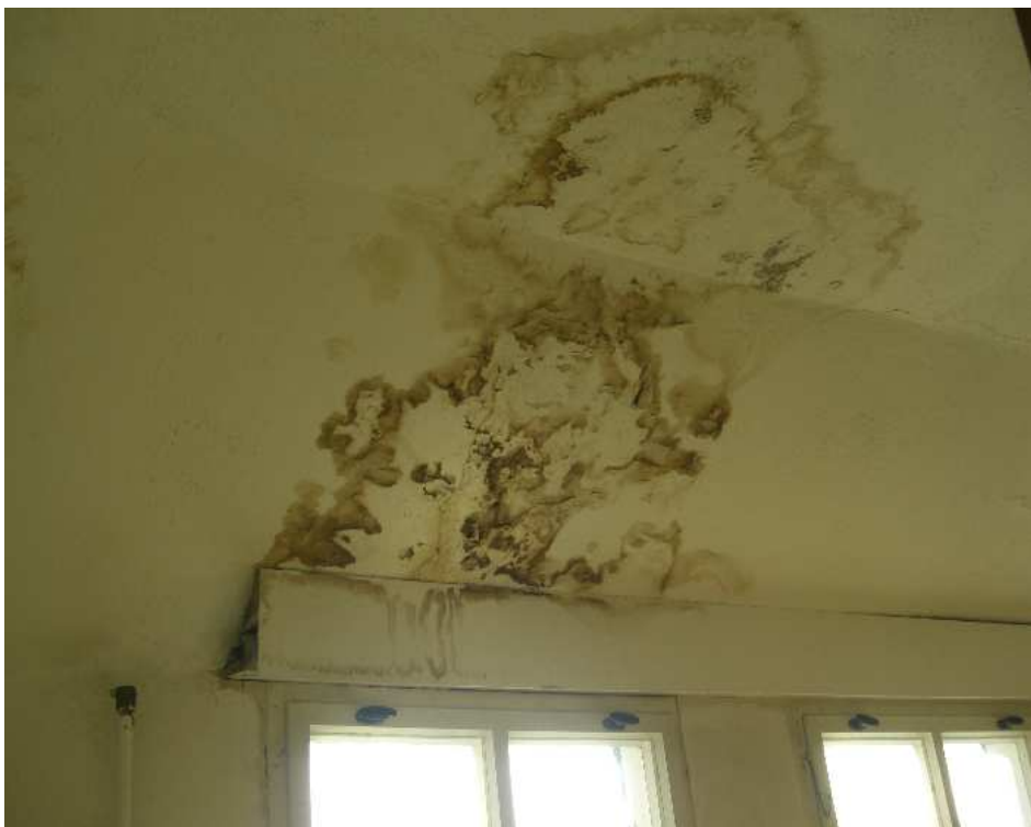
- Feuchtigkeitsschäden Dachgeschoss Schulgebäude -
