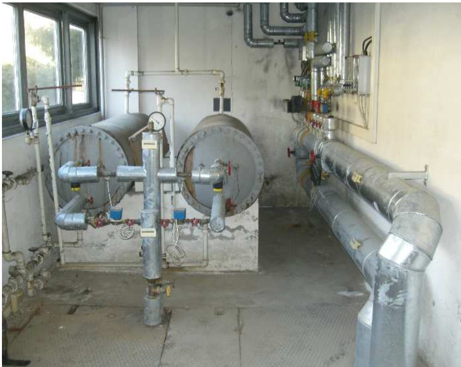
- Ansicht Heizungsübergabestation mit Warmwasserboiler Turnhalle -
