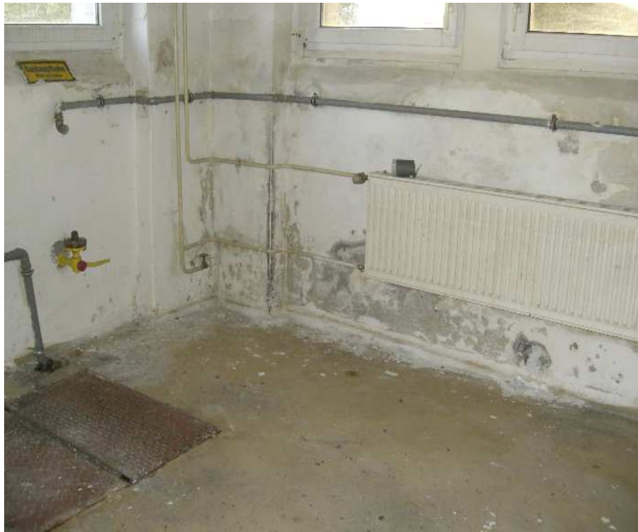
- Putz-und Feuchtigkeitsschäden Keller Schulgebäude -
