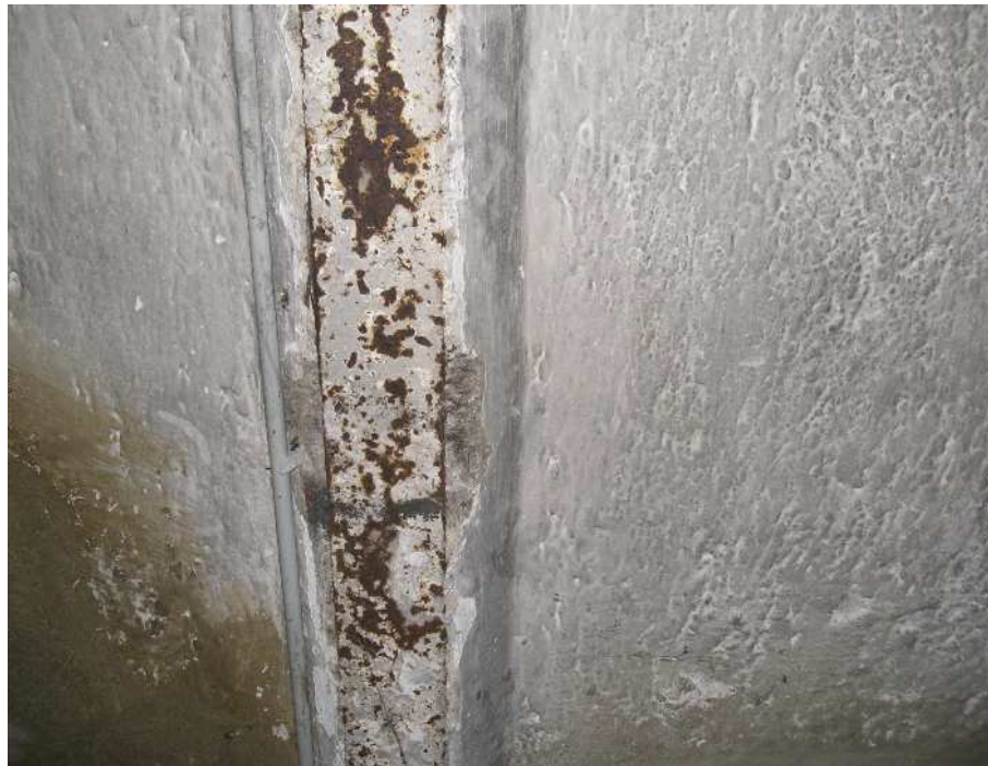
- Korrosionsschäden Kellerdeckenträger Schule -
