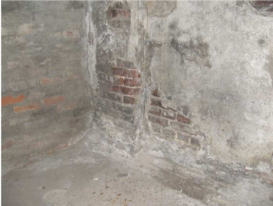
- Putz-und Feuchtigkeitsschäden Keller Schulgebäude -
