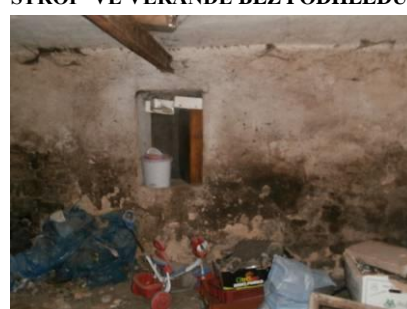
1.NP SKLAD - KOTELNA, SKLAD, SKLAD - ZVÝŠENÁ VHLKOST STĚN, VNITŘNÍ OMÍTKY U KONCE ŽIVOTNOSTI
