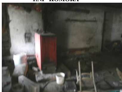
1.NP SKLAD - KOTELNA, SKLAD, SKLAD - ZVÝŠENÁ VHLKOST STĚN, VNITŘNÍ OMÍTKY U KONCE ŽIVOTNOSTI
