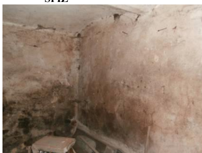
1.NP SKLAD - KOTELNA, SKLAD, SKLAD - ZVÝŠENÁ VHLKOST STĚN, VNITŘNÍ OMÍTKY U KONCE ŽIVOTNOSTI
