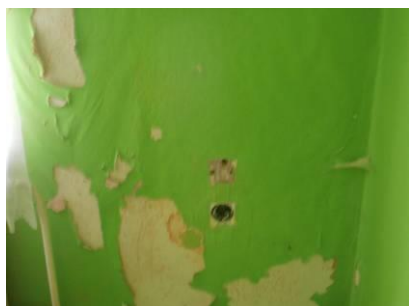
POŠKOZENÉ VNITŘNÍ OMÍTKY V BYTĚ
