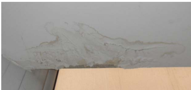
Lokální zatečení u fasádního atypického okna
